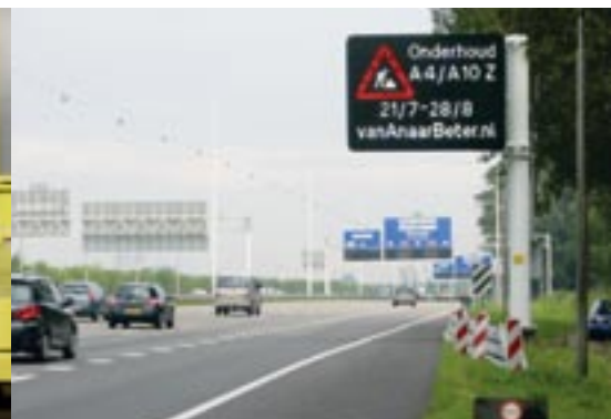
De vrij te programmeren berm-DRIPS beïnvloeden de doorstroming positief.
